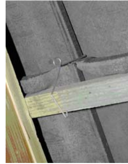
Photo 1: Crochet d'ancrage E-clips type 1 pour tuile en béton SNELDEK ROYAL
