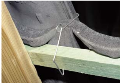
Photo 1: Crochet d'ancrage E-clips type 1 pour tuile en béton SNELDEK ROYAL
